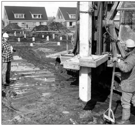
Jeen Jager van bouwbedrijf Kootstra van der Veen en Jelle Lootsma kijken nauwlettend hoe hun machinist Gabe Boonstra één van de heipalen op de juiste plek plaatst. Eigen foto
